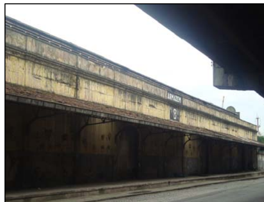
Visão do Armazém 8.
